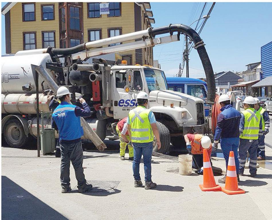
Se habría detectado punto de filtración de aguas servidas a ducto de aguas lluvias
